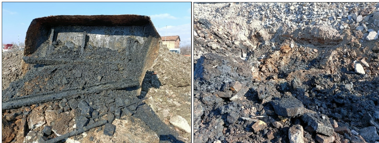
Figura 5: cisterna in acciaio rinvenuta sotto una soletta in calcestruzzo e dettaglio del terreno nel suo intorno
