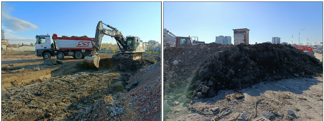
Figura 3: fasi di scavo e cumulo di terre di fonderia da smaltire
